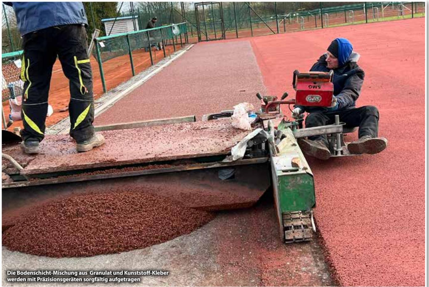
Die Bodenschicht-Mischung aus Granulat und Kunststoff-Kleber werden mit Präzisionsgeräten sorgfältig aufgetragen
